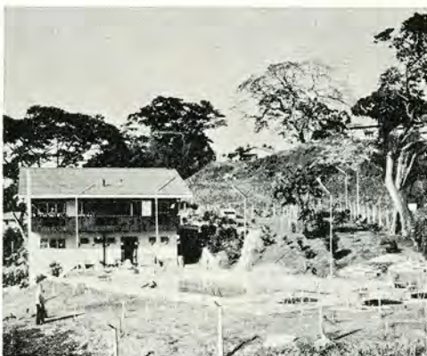
Slik ser det altså ut etter at svømmebassenget er ferdig.
